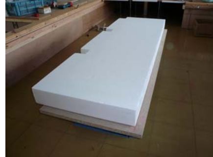
印に合わせて断熱材を置く。
