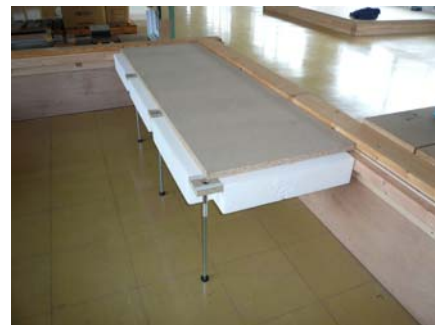
その後、パネルを敷設する。
