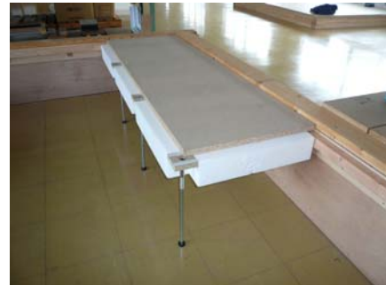
その後、パネルを敷設する。
