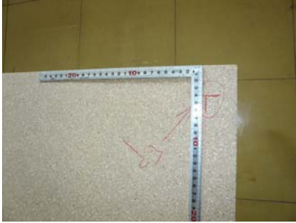
パーチに断熱材を貼る位置の印を付ける。
