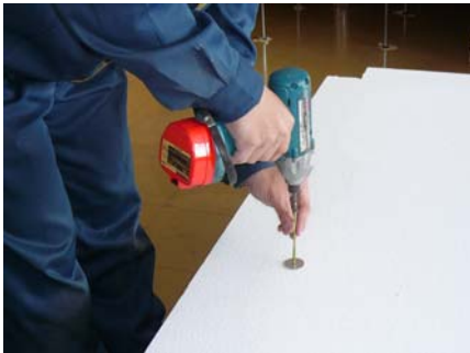
ビスφ4.2×120 にはφ30×0.4 t 座金を付け断熱材をパネルに固定する。
